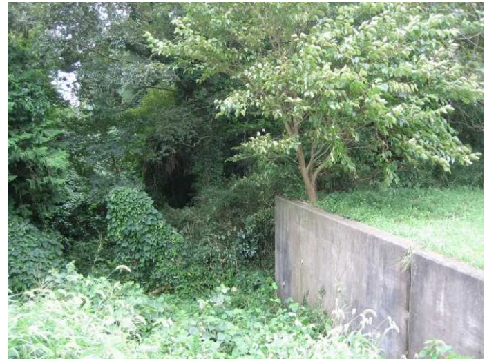
【拡大写真(擁壁の安全性が確認できない)】
