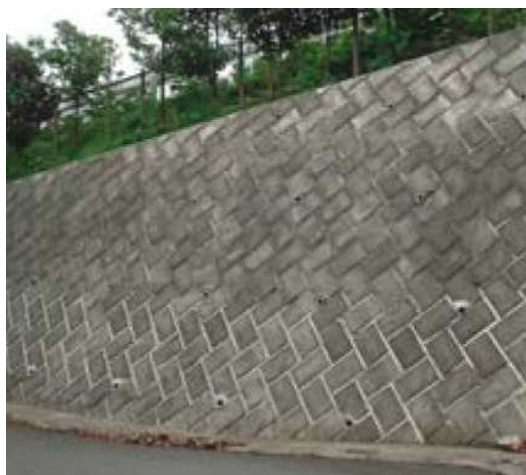
間知石積擁壁(○)
