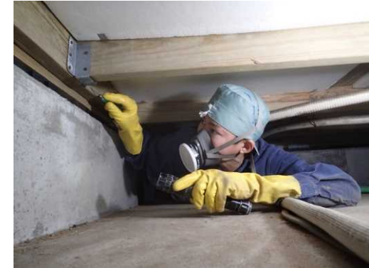
床下の木材の目視検査
