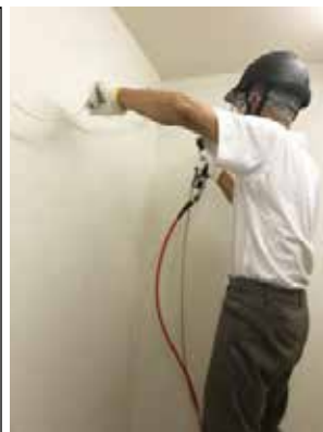
待合壁施工前 施工後
